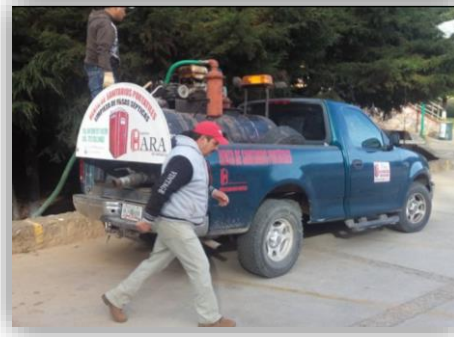
Limpieza de Fosas Sépticas
